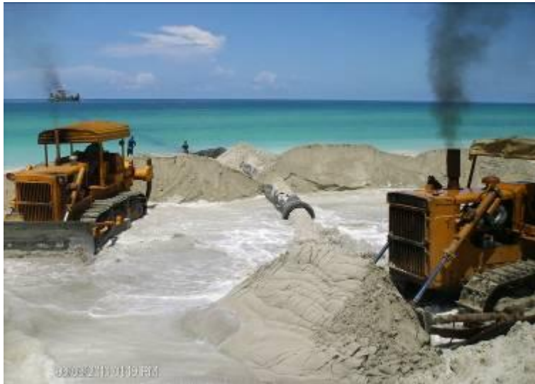
Figura 45 Trabajos de regeneración de playa Varadero, Cuba
