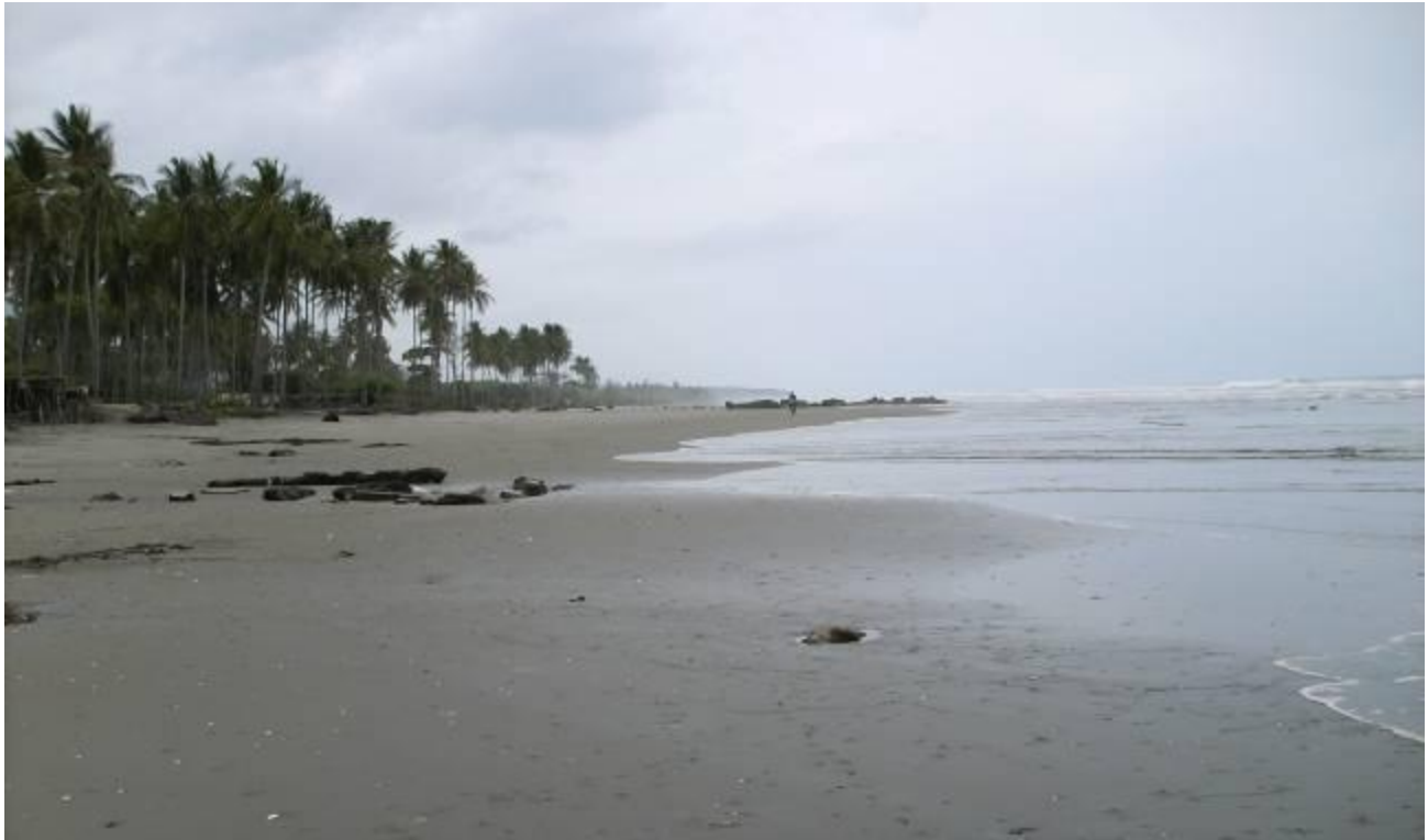
Figura 21. Espigón con acumulación de arena en la margen oeste-noroeste
