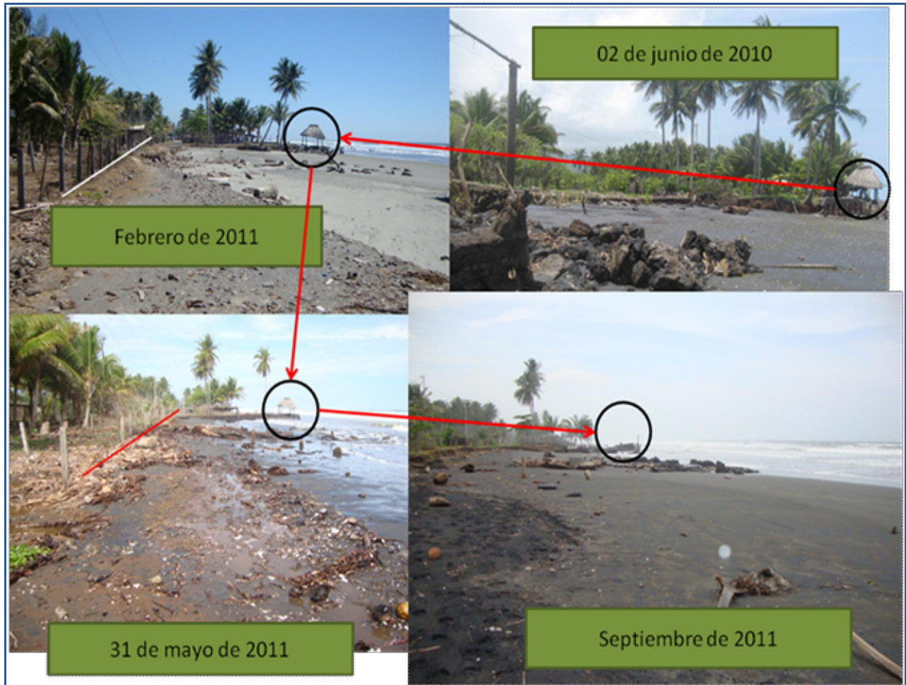
Figura 17. Efectos de la erosión en los últimos años
